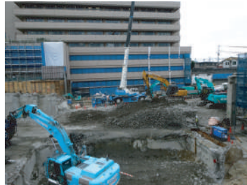
昨年9月27日、総合病院建替特別委員会で現地視察をしました。南棟地下躯体の解体工事中です。
